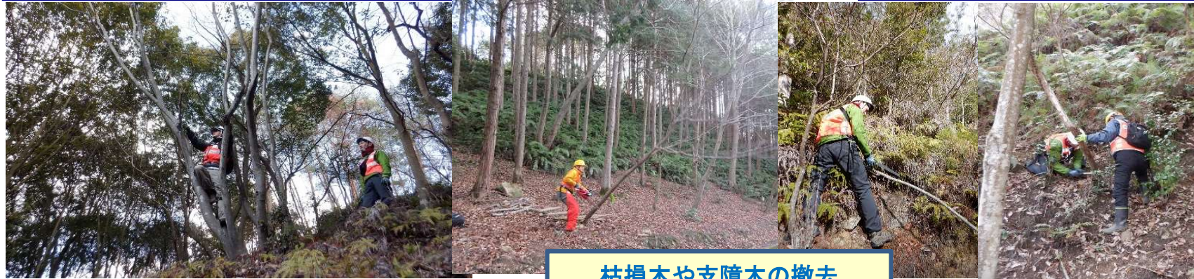
枯損木や支障木の撤去
