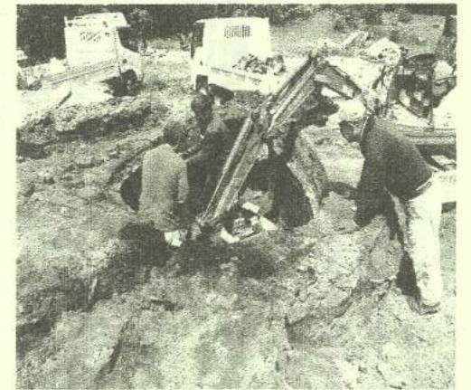
A窯の解体作業。耐火レンガ剥がしているところです
